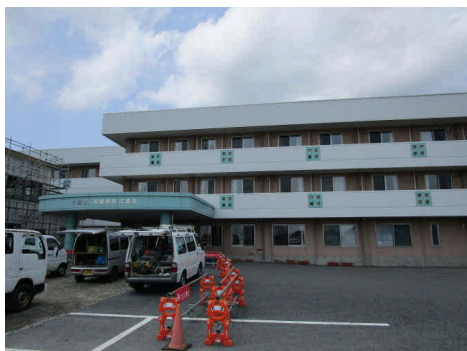
初夏の陽気の日です。江風苑は建て増し工事中でした。
